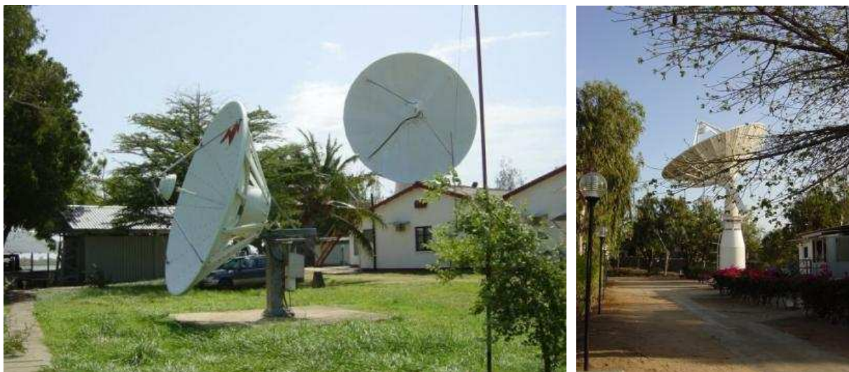
Antenne radio della Base a Malindi (Fonte: ASI).
