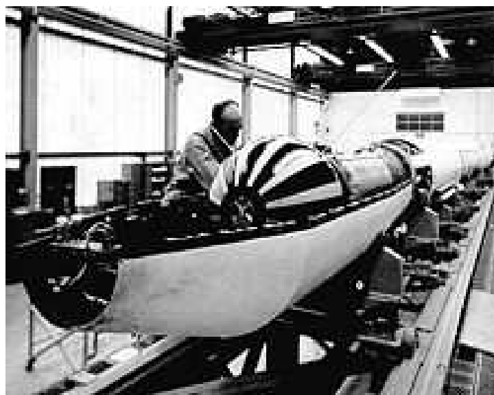
Due momenti dell'allestimento del satellite San Marco A nel razzo vettore.
